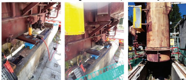
Mise en place des « galets rouleurs » (en bleu sur les images)
