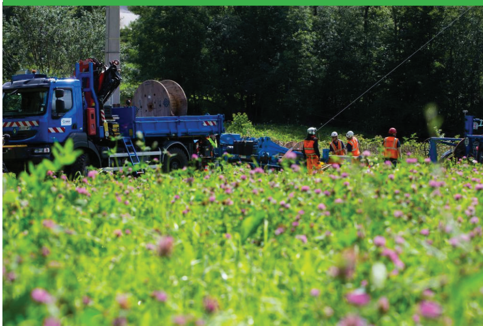
Tirage de Câbles
