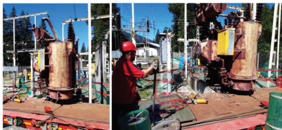
Treuilage du transformateur
