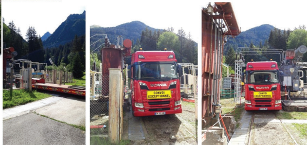
Accès dans l'enceinte du Poste Source
