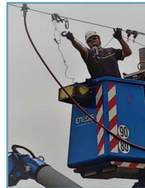
Travaux sous tension (source ENEDIS)
